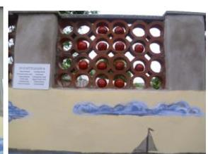
Die Kugel, Würfel und Pyramiden aus glasiertem Ton wurden über der Reliefwand in Tonröhren eingesetzt.
